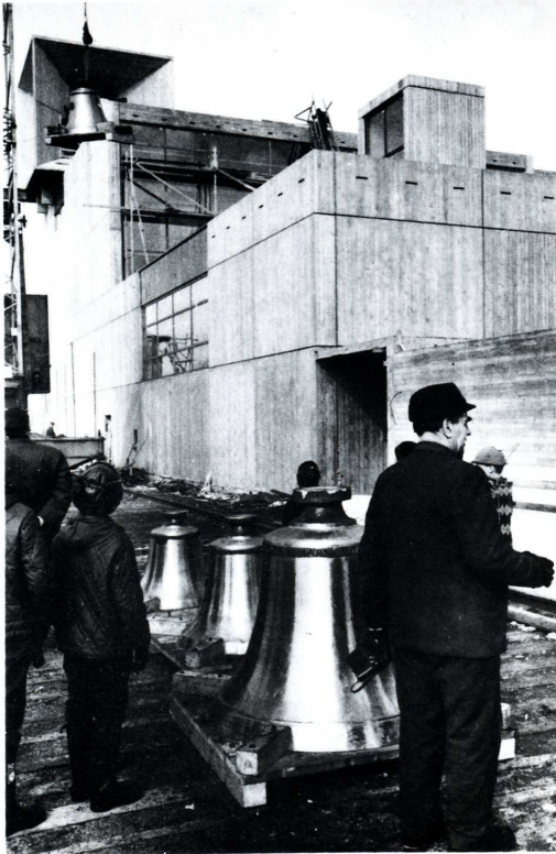
Kirkon rakentamisessa meneillään kellojen asennus v. 1968.
