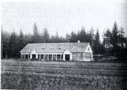
Seutulan konerakennus, myöhemmin mattotehdas. (Hakon West. kok.)
